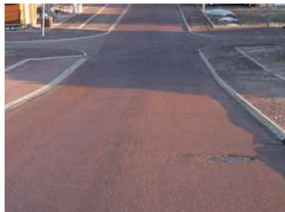
Réfection de la voirie et des trottoirs...
